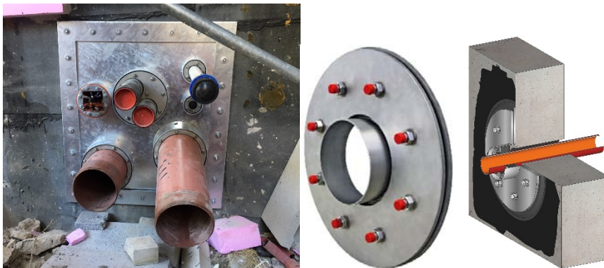
Bílá vana, rekonstrukce – vstup stěnou/základovou deskou
